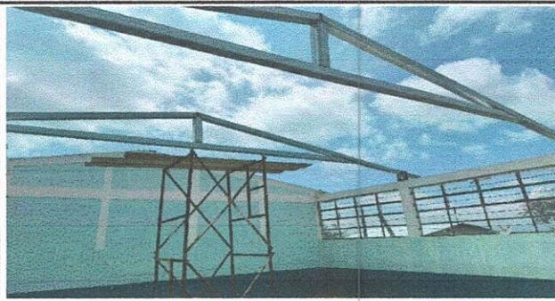
Foto 5: Instalación de costaneras interior aulas
