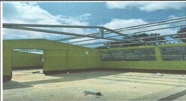
Foto 6: Instalacion de costaneras interior aulas
