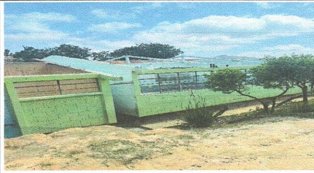
Foto 2: Instalación de costaneras bodega y cocina
