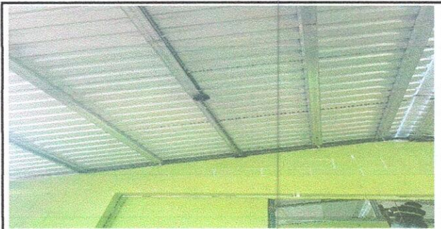
Foto 3: Instalación de plafoneras en el techo de las aulas
